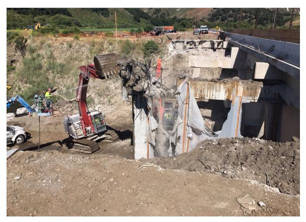
Figure 6-20. Bent Cap Removal, Salsipuedes Creek
